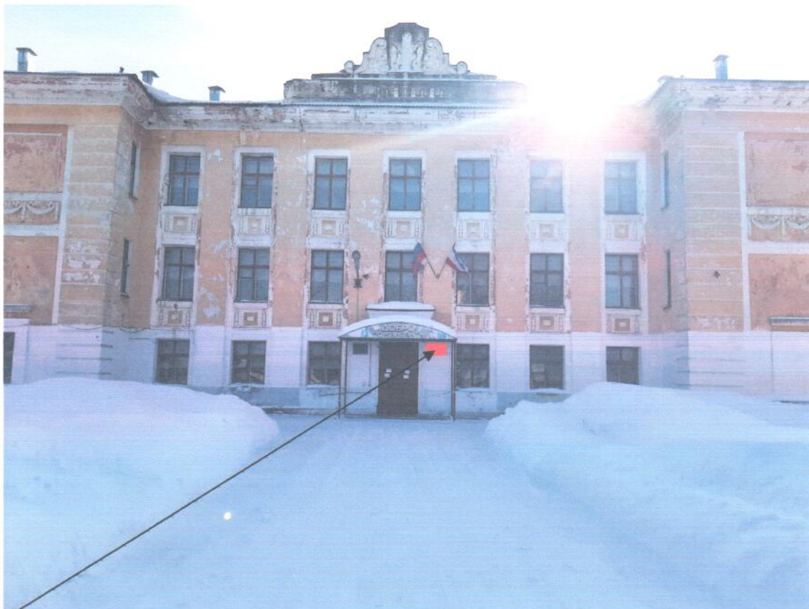
Фото фасада с привязкой к месту установления информационной надписи.
